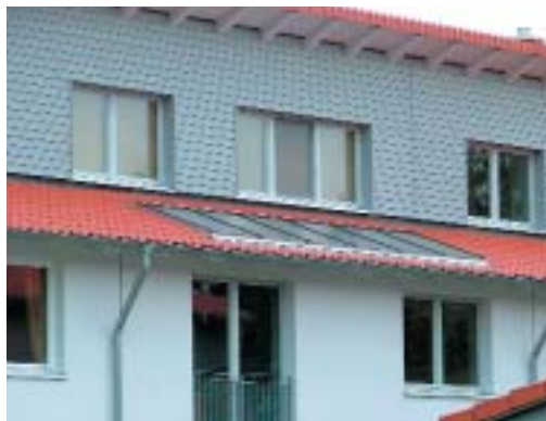
Thermische Solaranlage harmonisch ins Dach integriert
