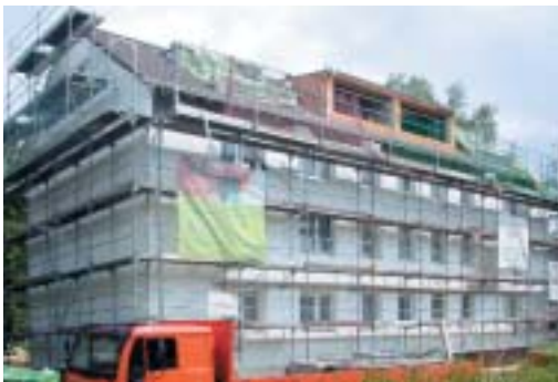
Projekt „Homannstraße“ der KSG während der Bauphase
