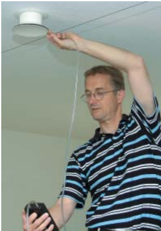
Einmessung einer Komfortlüftungsanlage
