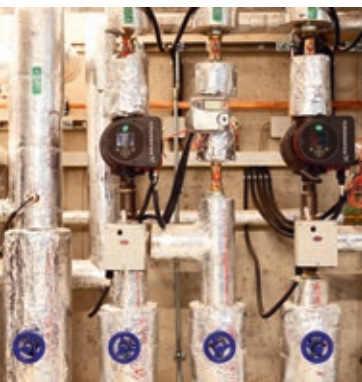
In den Wohngemeinschaften sind die Küchen möbliert, hinter einem Küchenschrank verbirgt sich die Lüftungsanlage (oben). Auch die Dämmung der Rohre trägt zur Verbrauchsminderung bei (unten).
