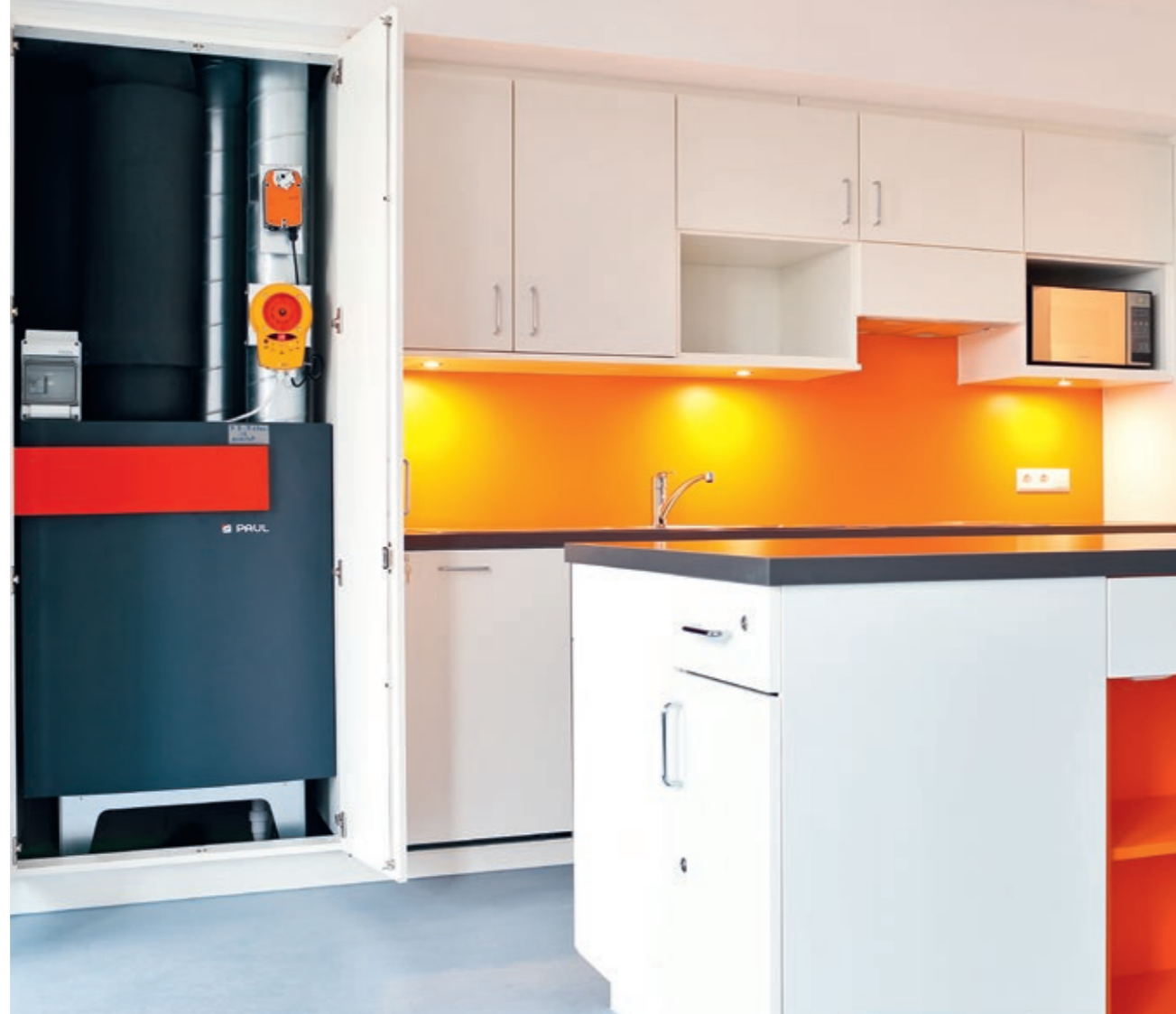
In den Wohngemeinschaften sind die Küchen möbliert, hinter einem Küchenschrank verbirgt sich die Lüftungsanlage (oben). Auch die Dämmung der Rohre trägt zur Verbrauchsminderung bei (unten).
