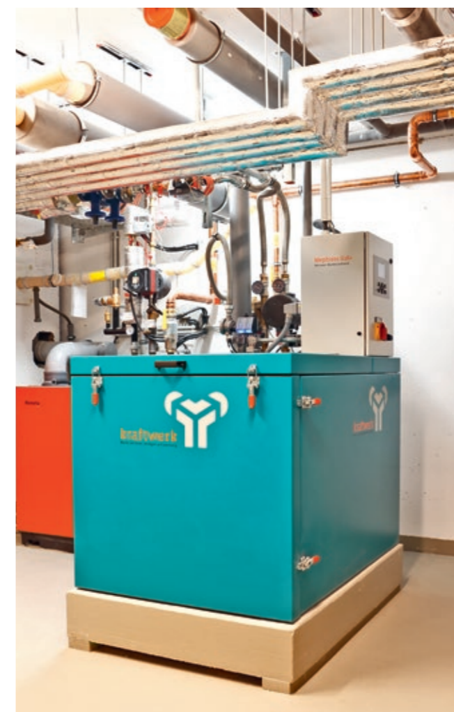
Deckt zwei Drittel des Strombedarfs: das Blockheizkraftwerk im Keller.
