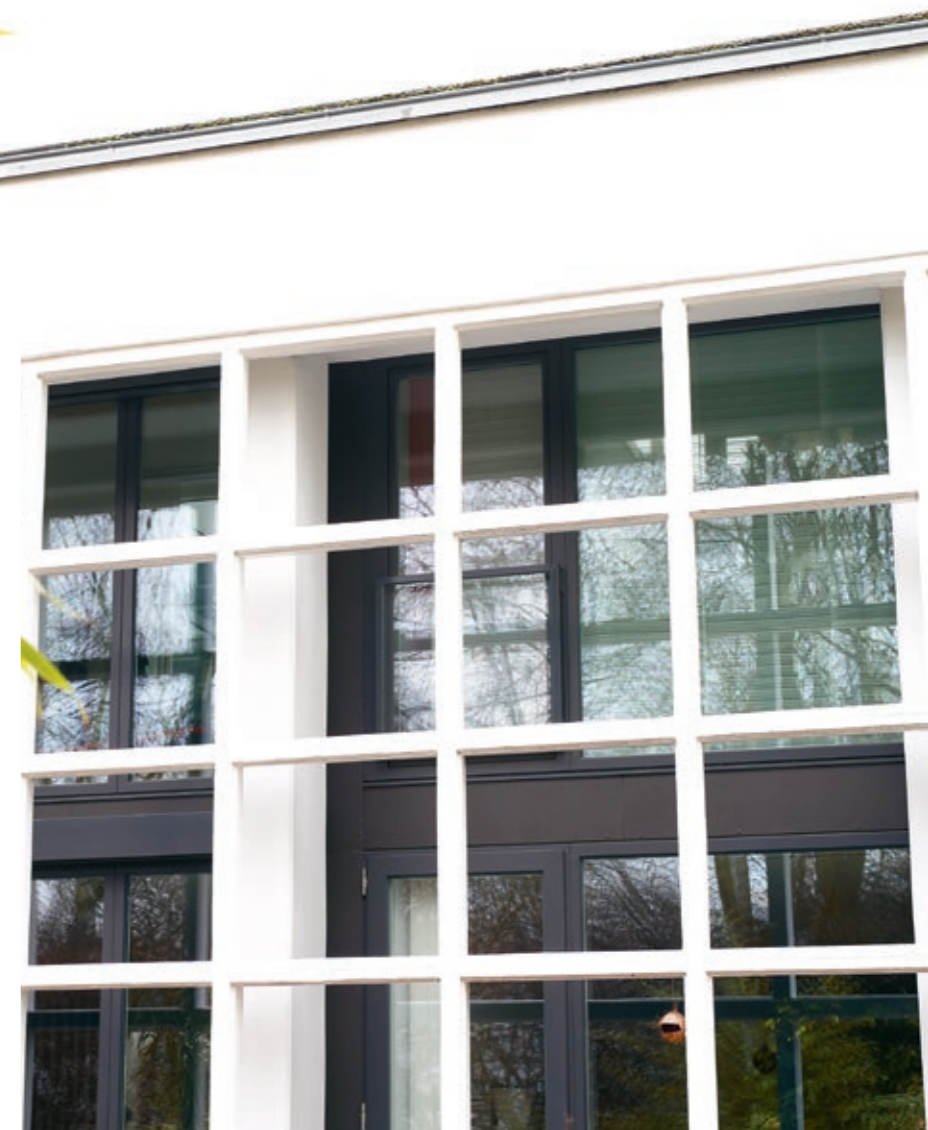
Die Gitterstruktur der alten Turnhalle blieb vollständig bestehen. Dahinter befinden sich kleine Balkone.
