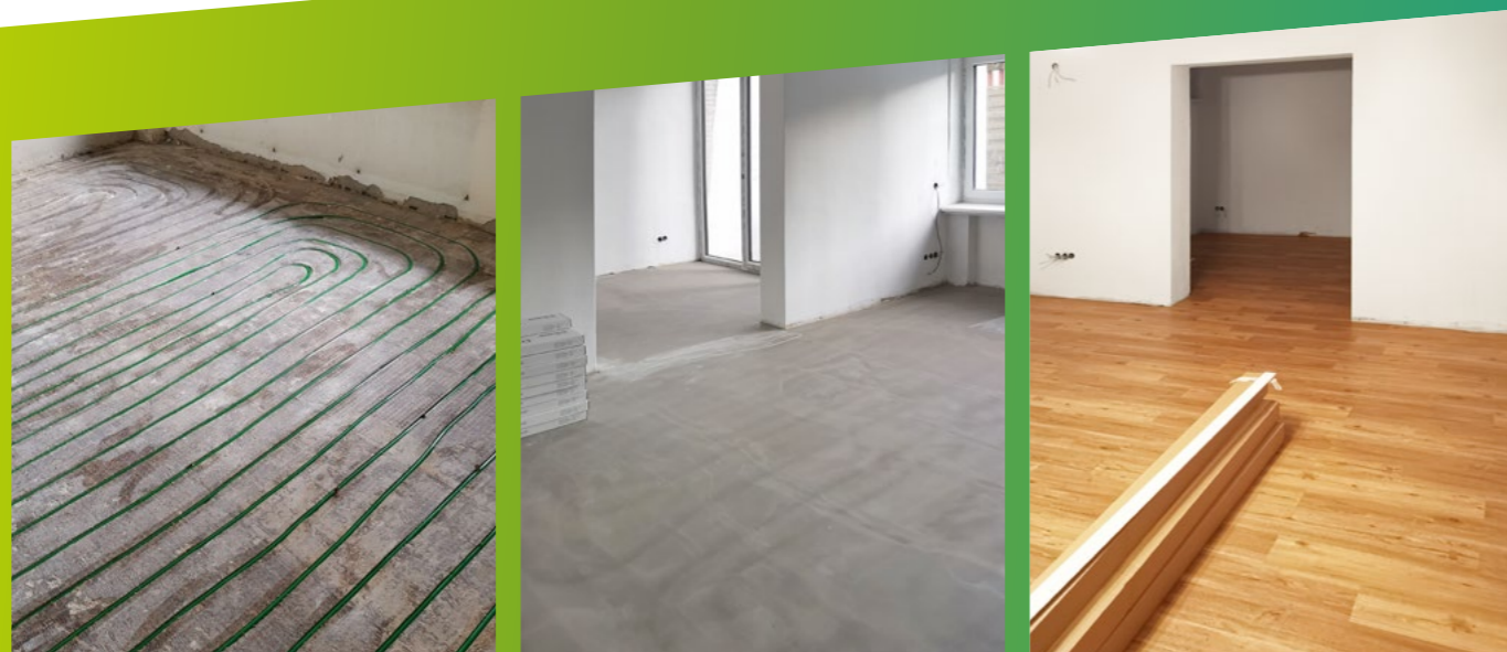
Einbau einer Fußbodenheizung im Bestandsgebäude mit Verlegung der Schläuche im gefrästen Bestandsestrich
