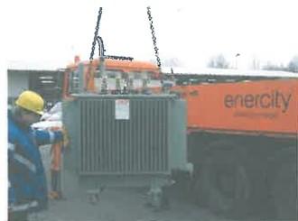
Transformatorenaustausch Stadtwerke Hannover AG
