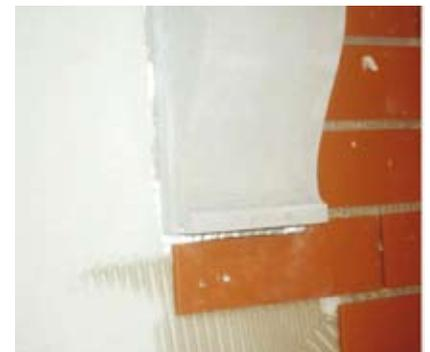
Wärmedämmverbundsystem getarnt als historisches Backsteinmauerwerk
