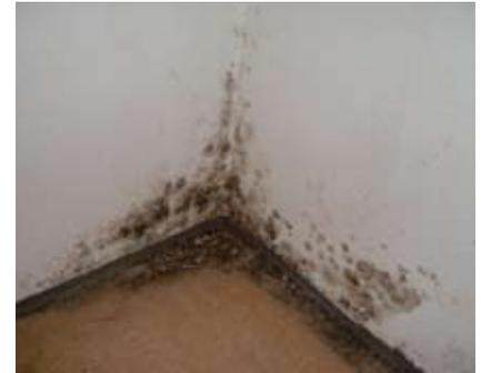
Schimmel in einem Gebäude mit 6 cm Dämmung in einer Außenecke hinter einem Schrank
