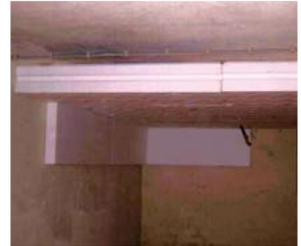
*Kellerdeckendämmung mit 14 cm Polystyrol*
