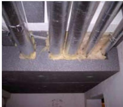
*Leitungsführung innerhalb der gedämmten Gebäudehülle im Bereich der Kellerdeckendämmung*
