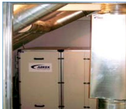
Lüftungszentrale auf kleinstem Raum; flexible Schalldämpfer direkt vor dem Deckenschott zur Wohnung
