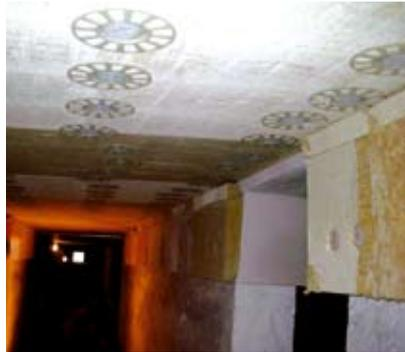
*Dämmung der KG-Decke mit Mineralfaserdämmung 20 cm dick*
