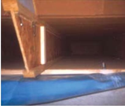
*I-Profil mit 36 cm Höhe: Raum für ausreichend Wärmedämmung*
