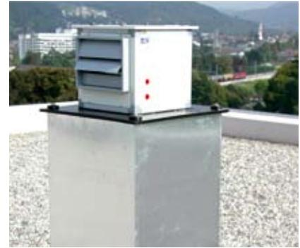
Abluftventilator für einen Steigstrang als Zentralgerät auf dem Dach mit Schalldämpfer im Sockel
