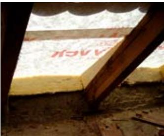
Wärmebrückenminimierung an der Traufe mittels Aufschiebling
