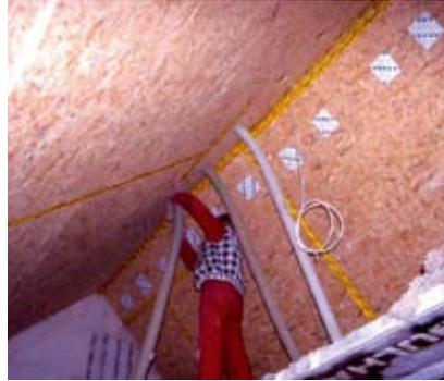
*Schrägdach-Dämmung mit Zellulose-Einblasdämmung*
