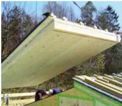
*Einsatz von vorgefertigten Vakuumdämmelementen (Quelle: Variotec)*
