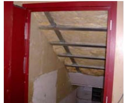
Kellerabgang: Wärmebrückenarm und luftdicht
